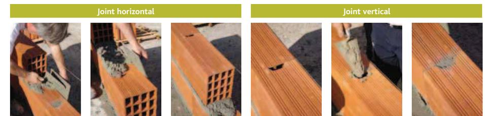
La mise en œuvre doit être conforme aux prescriptions du DTU 20.1. Déposer le mortier sur la face lisse de la brique. L'épaisseur finie du mortier entre deux rangées devra être comprise entre 10 et 20 mm.
