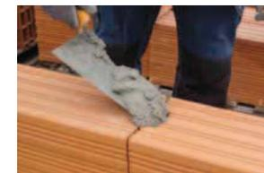
Les briques sont posées jointives, la gorge donnant automatiquement l'emplacement du joint vertical. Les joints sont réalisés par remplissage des gorges.
