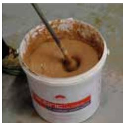
Mélanger le mortier Calibric® à raison de 7 à 7,5 litres d'eau pour un sac de 25 kg, en respectant l'ordre d'introduction suivant : eau puis poudre.
