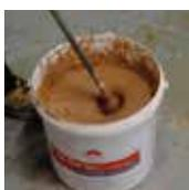
Mélanger à l'aide d'un malaxeur électrique le mortier colle Calibric® à raison de 7 à 7,5 litres d'eau pour un sac de 25 kg, en respectant l'ordre d'introduction (eau puis poudre) jusqu'à obtention d'un mélange homogène sans grumeau.
