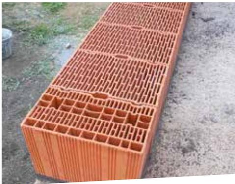
La pose régulière du mortier colle est obtenue grâce à la roulette Calibric® sur une épaisseur de 3 mm.
