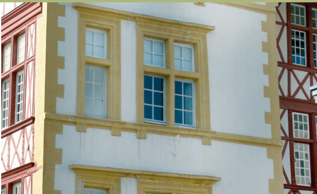
Façade en badigeons à base de CAEB. Quai Jaureguiberry, Bayonne (64).
