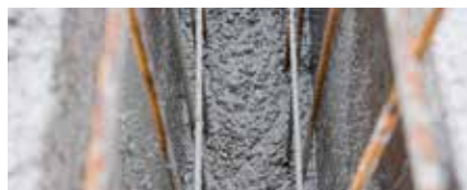
Murs à bancher
