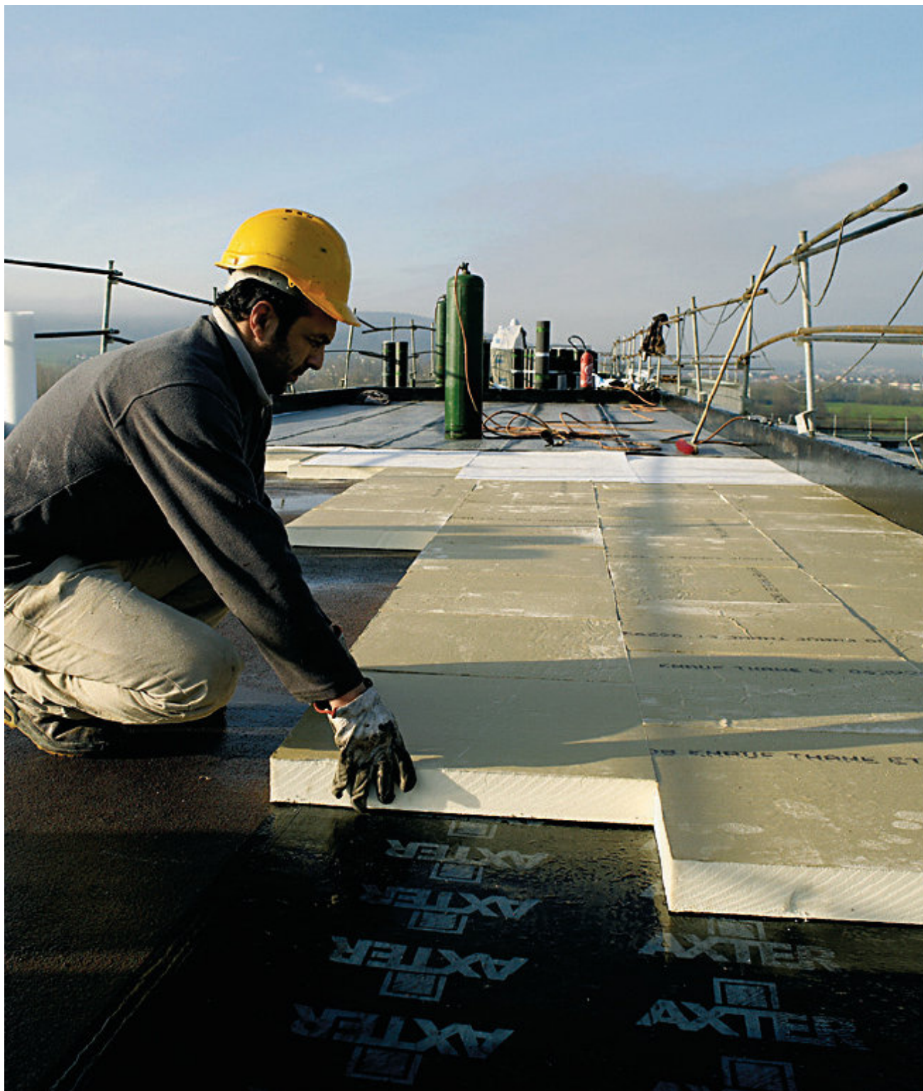
Pose libre des panneaux Knauf Thane ET Se sur le pare-vapeur
