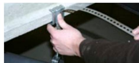
5 - La partie supérieure de la patte qui remonte au-dessus du niveau de la suspente est tout simplement recourbée pour permettre la mise en place des entrevous Leader EMS.
