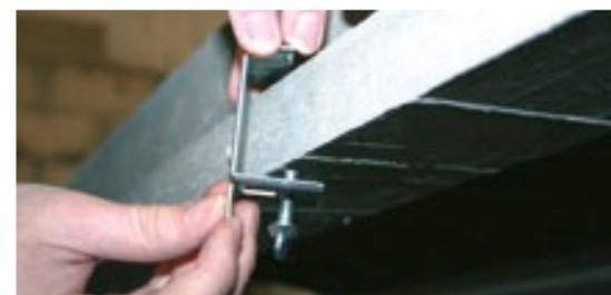
1 - Mise en place de la Suspente VS sur le talon de la poutrelle et serrage à l'aide de l'écrou papillon.
