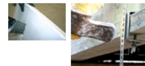
4 - Accrocher la patte à la hauteur voulue grâce aux ergots de fixation prévus à cet effet sur la Suspente VS. Si besoin, pour éviter des mouvements verticaux, enfoncer les ergots à l'aide d'un marteau.
