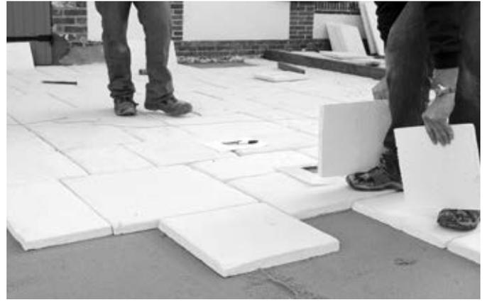
Mise en place des dallages (ici des dalles Castellane en opus multiformat) sur lit de sable parfaitement de niveau.
