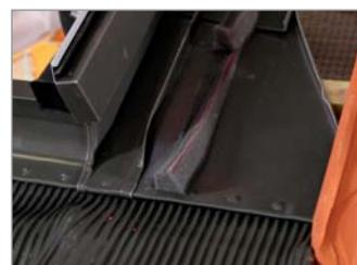
Installez le bandeau de mousse, adaptez-le au cutter si nécessaire puis placez les tuiles autour du bâti.... Voilà, il suffit maintenant de remettre la fenêtre et la pose est terminée.
