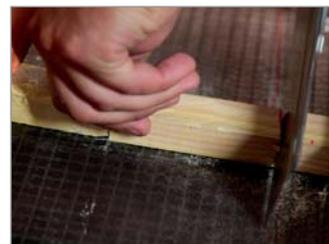
**Posez la gouttière avec une légère pente** et marquez son emplacement sur les liteaux. Descendez ensuite la gouttière de 8 cm et tracez une droite sur l'écran de sous-toiture. Sciez les liteaux pour encastrer la gouttière, tranchez l'écran au cutter puis arrasez l'excédent du pare-pluie de cette façon. Installez enfin la gouttière et fixez par deux clous.
