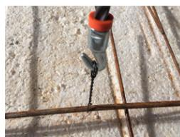
Sert à ligaturer sacs, clôtures et ferrailages pour béton armé.
