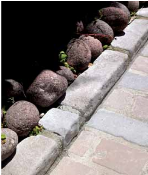
BORDURES CALCAIRE DU CAUSSE VIEILLIES
