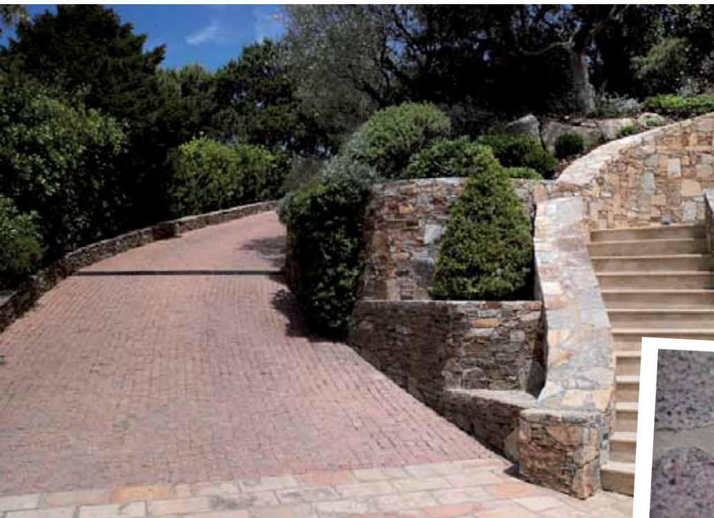
PAVÉS GRANIT VARÈSE ET PIERRE A BÂTIR GNEISS DU CAROUX
