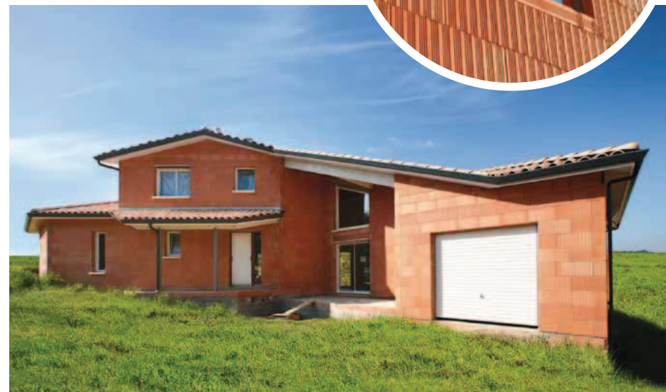
Maison individuelle (31) – Architecte : P. BALAGUE
