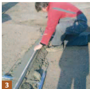
3 Réaliser l'arase au mortier hydrofugé à l'aide d'une règle. Constituer ainsi une arase périphérique parfaitement de niveau (Ep. minimum 2 cm).
