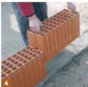
4 Poser les briques du premier rang sur le mortier.
