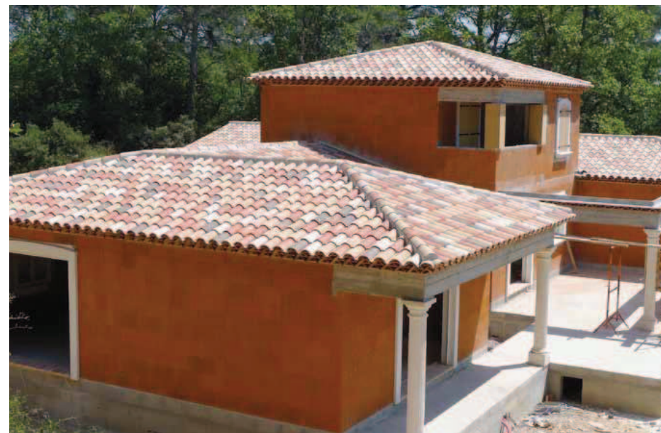
Maisons individuelles à LORGUES (83) - Constructeur : LES MAISONS VERTES DU VAR (83)
