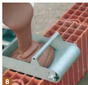
8 Si le mortier s'est épaissi, il suffit de le malaxer légèrement, sans ajout d'eau, pour le fluidifier à nouveau.
