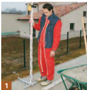
1 A l'aide d'un niveau laser, déterminer le point haut de la dalle.
