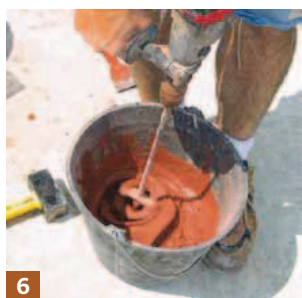
6 Malaxer mécaniquement un sac de 25 kg avec 8 à 9,5 litres d'eau propre. Durée de malaxage : 3 minutes. Durée d'utilisation : 1h30 à 2h suivant les conditions atmosphériques.
