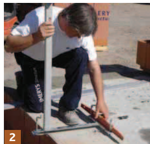
2 A l'aide d'un niveau laser et des platines, réaliser le niveau du premier joint de mortier au point haut de la dalle.
