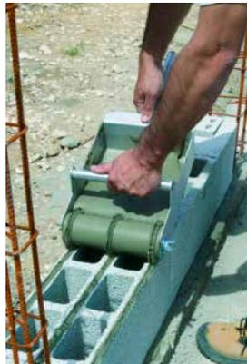
**Démarrer la pose** par les angles comme au premier rang. Poser les blocs à joints croisés (conformément au DTU), vérifier l'horizontalité à chaque pose de bloc. Pour finir le rang, utiliser les blocs modules et, ou les blocs ajustables étudiés pour supprimer les coupes.
