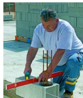
**Aligner** à l'aide d'un cordeau les autres blocs, tout en vérifiant leur horizontalité dans la largeur et la longueur du bloc.
