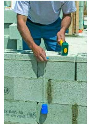
**Pour le rang précédent la pose des appuis de fenêtre, des chaînages ou avant le plancher : utiliser les blocs borgnes.**
