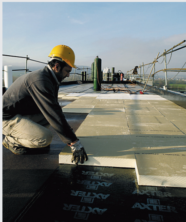
Pose libre des panneaux Knauf Thane ET sur le pare-vapeur.
