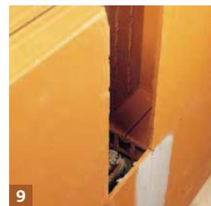
**9** Le montage du CARROBRIC de 15 cm est réalisé systématiquement au liant colle maçonnerie. Le CARROBRIC de 15 cm offre la possibilité d'incorporer des armatures verticales et horizontales, ainsi que des poteaux d'angles.
