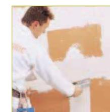
Les joints sont traités sur une grande largeur. Ils sont exécutés au liant colle à l'aide d'un plâtre ou d'un couteau. Dans le cas d'un revêtement épais (CARROFEU), carrelage... ils seront simplement coupés au séchage.
