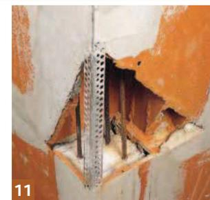
Le montage du CARROBRIC de 15 cm est réalisé systématiquement au liant colle maçonnerie. Le CARROBRIC de 15 cm offre la possibilité d'incorporer des armatures verticales et horizontales, ainsi que des poteaux d'angles. Le CARROBRIC de 15 cm peut être utilisé en extérieur. De plus, son classement en catégorie A permet l'utilisation d'enduits lourds, y compris monocouche. Réservez : **9** - Chaînage horizontal : **10** - Poteaux d'angles : **11**.
