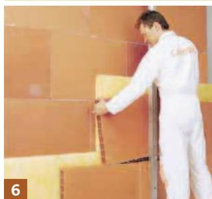
**6** Réaliser, pour chacune des 2 cloisons, une désolidarisation périphérique à l'aide d'une bande résiliente caoutchouc. Après avoir monté la 1<sup>re</sup> cloison, plaquer la laine de verre et monter la 2<sup>de</sup> cloison.
