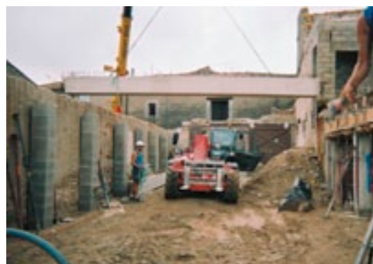
▲ Mise en place de la PSS par grue
