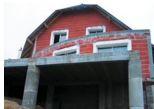
▲ PSS 20x20 en appui sur poteau
