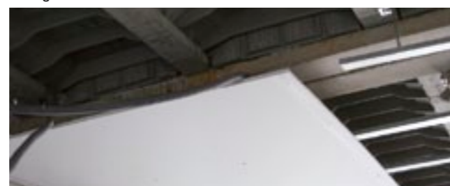
Mise en place du plafond sous la PM5
