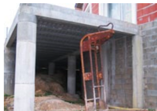
▲ PSS 20x20 en appui sur poteau
