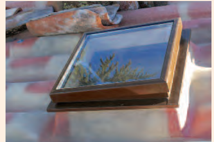
Pose de la fenêtre de toit
