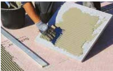
N'effectuer la pose à la colle que sur un support parfaitement sec, propre et dépoussiéré.
