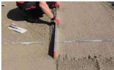
Étaler une couche de sable de rivière lavé que vous tirerez à la règle posée sur des cales de niveau. Après compactage le lit de pose doit avoir une épaisseur de 3 cm ± 1 cm.
