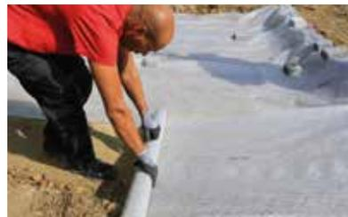
Poser une nappe géotextile sur le fond de votre fondation : cela limite la repousse de mauvaises herbes, stabilise votre ouvrage et assure un meilleur drainage.
