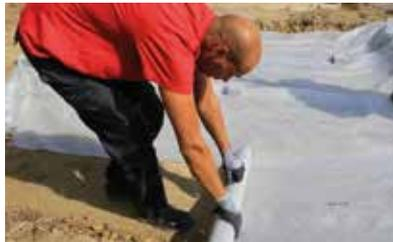
Poser une nappe géotextile sur le fond de votre fondation : cela limite la repousse de mauvaises herbes, stabilise votre ouvrage et assure un meilleur drainage.
