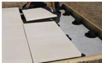
La hauteur maximale jusqu'à la sous face des dalles doit être  $\leq 15$  cm.
