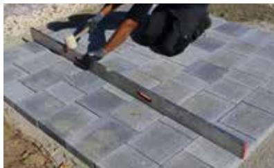
Poser les pavés à l'avancement en vous déplaçant sur les produits déjà posés. Vérifier la parfaite planéité du support.
