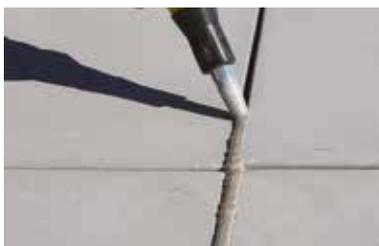
Pose sur sable : Procéder au remplissage des joints des dallages au sable (pas d'utilisation de sable polymère).
