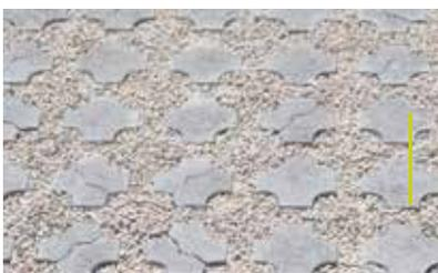
Pour préserver l'intégralité des arêtes supérieures de DALPRÉ et prévenir l'apparition d'épaufrures, il est nécessaire de procéder à un garnissage « à refus » (gravillon ou terre à engazonner).
