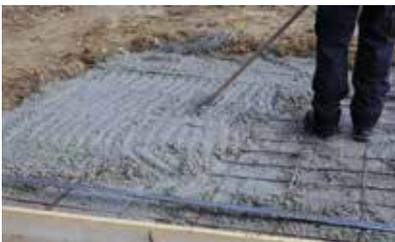
Mettre en place l'armature nécessaire et couler le béton sur l'épaisseur définie. Celle-ci peut varier en fonction des charges prévues.
