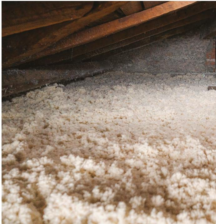
La gamme **Ouate de cellulose Cristal** est constituée d'isolants thermiques et acoustiques biosourcés particulièrement respectueux de l'environnement et font référence en confort d'été et en déphasage thermique.
