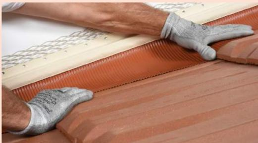
1 - Positionner le solin arrêt d'enduit en alignant si besoin à un traçage au mur fait préalablement. Entre chaque longueur de solin prévoir un recouvrement de 5 cm.
