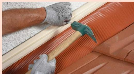
3 - Fixer le profilé au support à l'aide de cheville à frapper. Si nécessaire appliquer une pointe de mastic pour rendre la fixation étanche.
