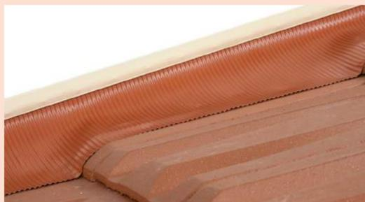
4 - Maroufler la bavette vers le creux des tuiles sans créer de retenues d'eau. Pour finir l'ouvrage appliquer l'enduit jusqu'au profilé.
