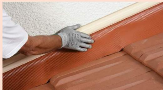
1 - Positionner le solin joint mastic en alignant si besoin à un traçage au mur fait préalablement. Entre chaque longueur de solin prévoir un recouvrement de 5 cm.
