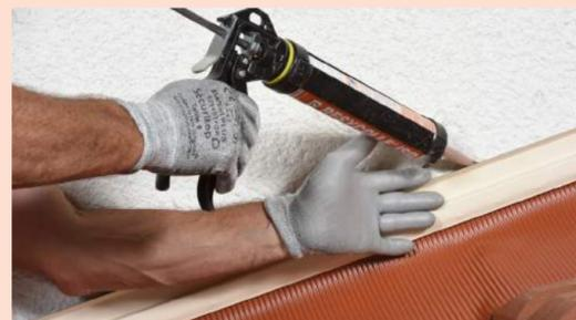
4 - Maroufler la bavette vers le creux des tuiles sans créer de retenues d'eau. Pour finir l'ouvrage appliquer un joint mastic résistant aux UV.
