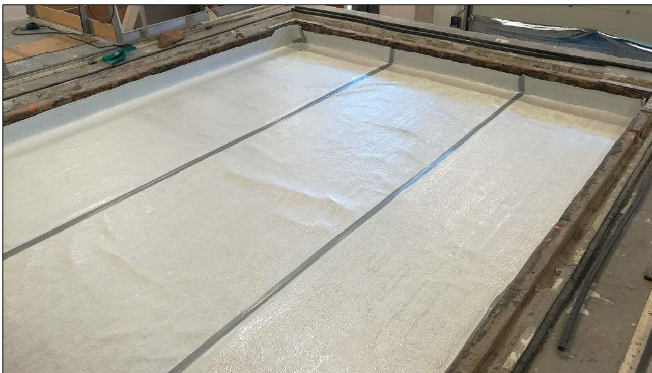
Mise en œuvre de la sous-couche mince
