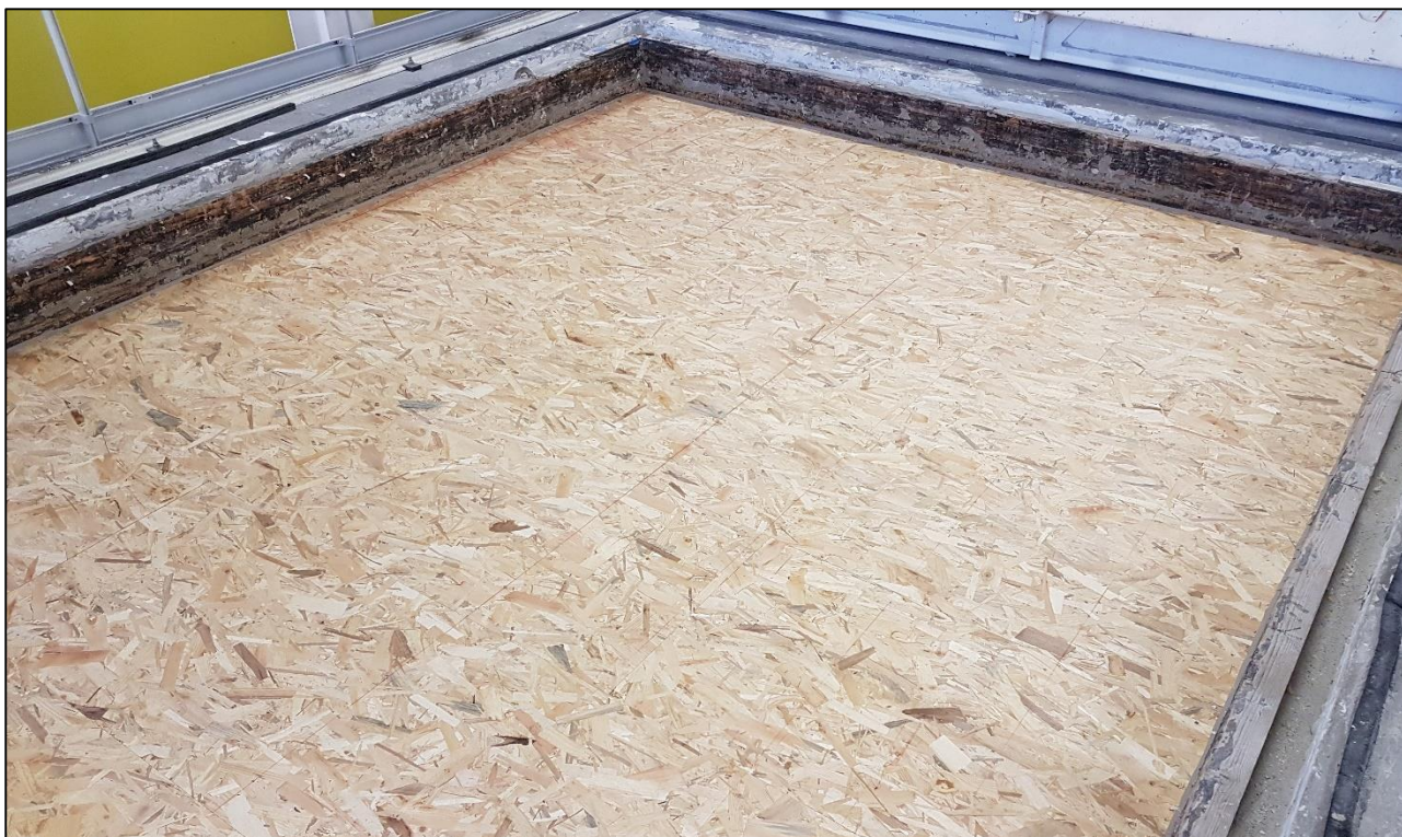
Mise en œuvre du plancher en OSB
