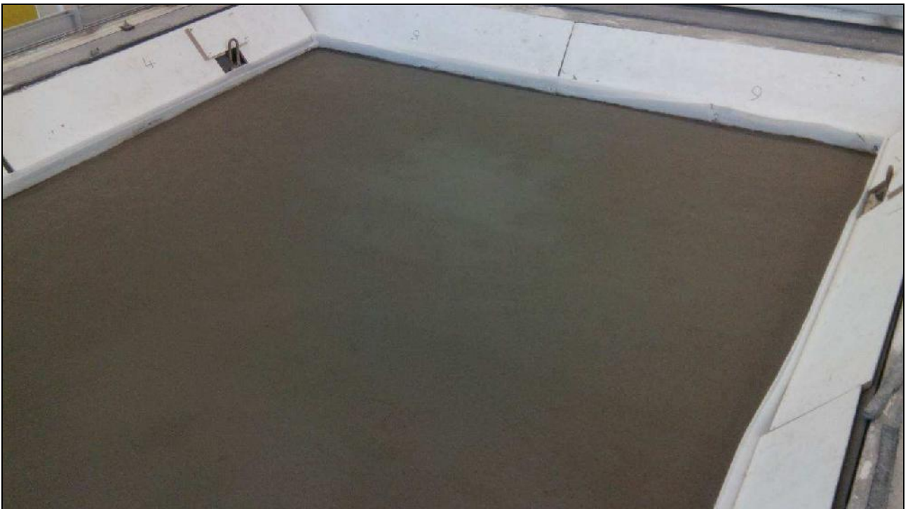
Mise en œuvre de la chape
