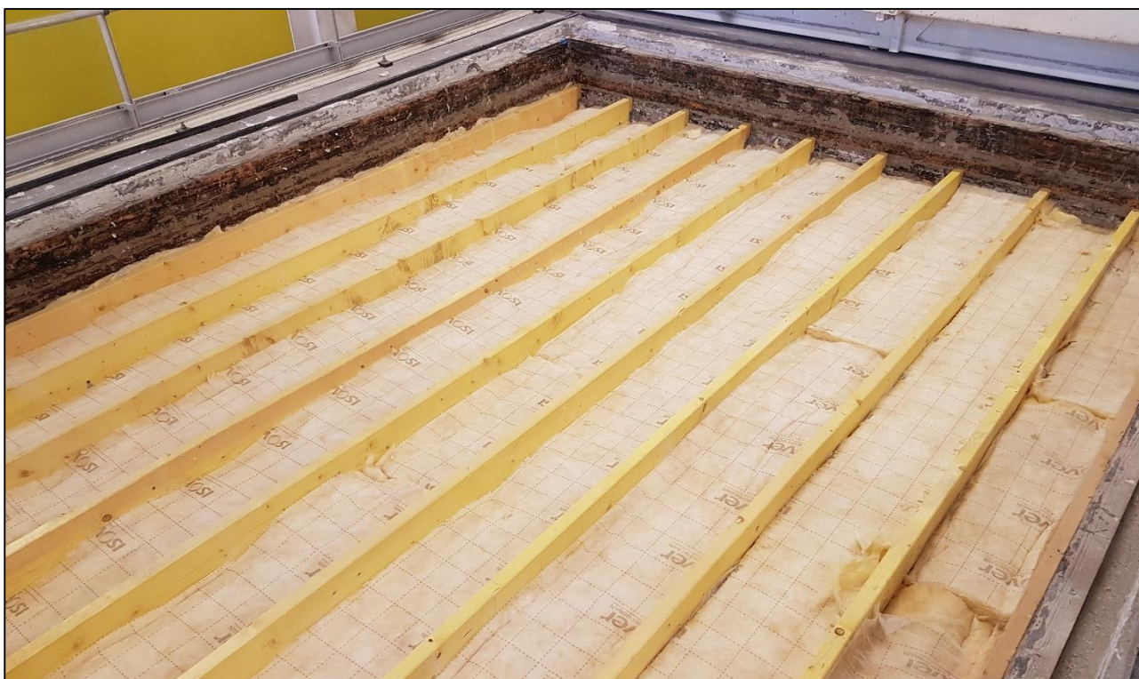
Mise en œuvre de l'isolant fibreux
