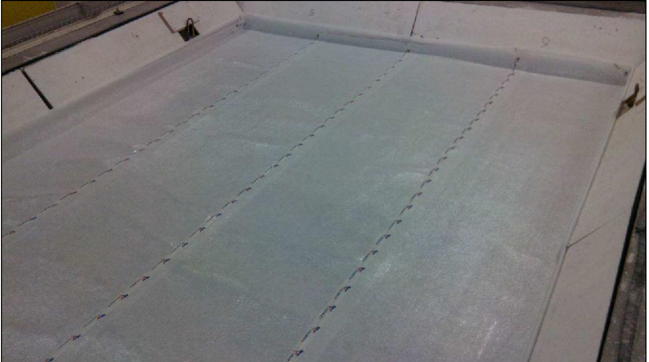
Mise en place de la sous-couche
