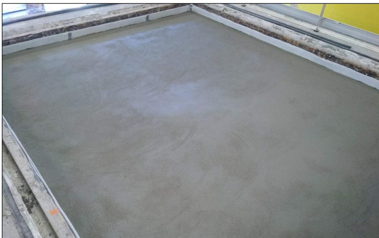
Vue de la chape avant séchage
