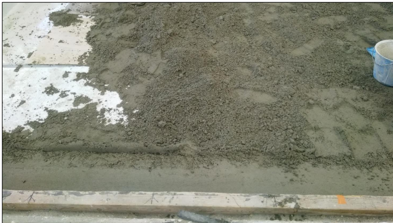
Mise en œuvre de la chape
